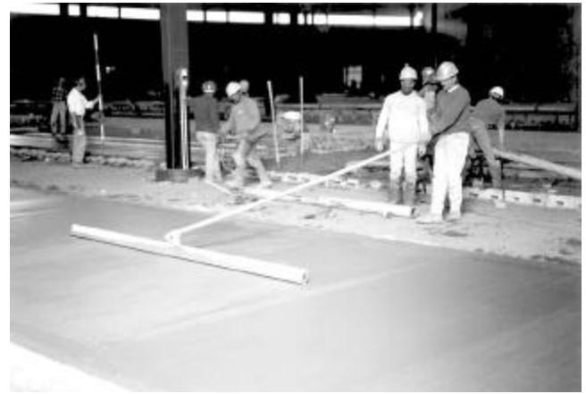
Fig. 8.2.5—“Modified highway” straightedge
